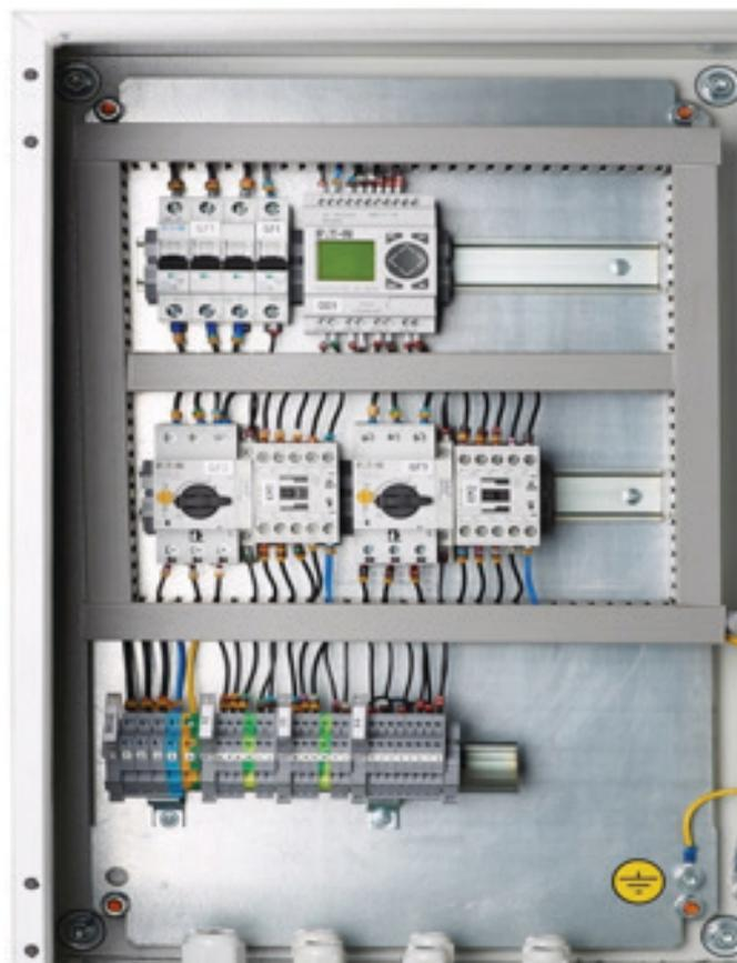
Рис. 7 ШУ-ЭЦ-3 – компоновка
